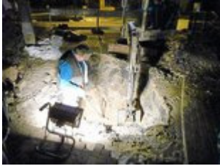
Noch am Samstagabend haben Trupps die Rohre repariert. Foto: (Uwe Renners)
